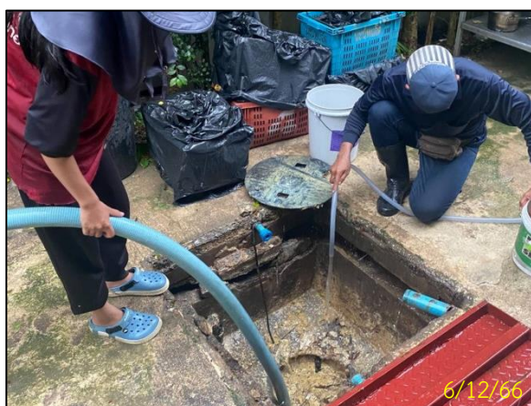
การสูบน้ำออกจากช่องแยกกาก และช่องตกตะกอน
