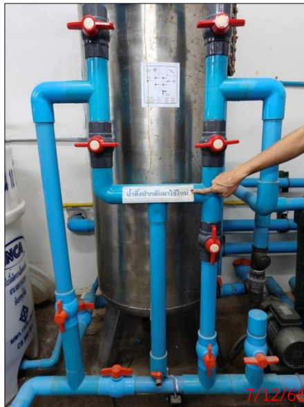
นำน้ำทิ้งจากระบบบำบัดน้ำเสียของโครงการที่บำบัดเพิ่มเติม นำกลับมาใช้รดพื้นที่สีเขียว
