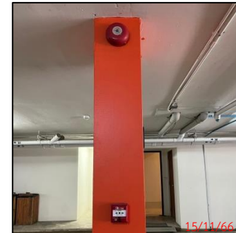
อุปกรณ์ส่งเสียงสัญญาณแจ้งเหตุ
